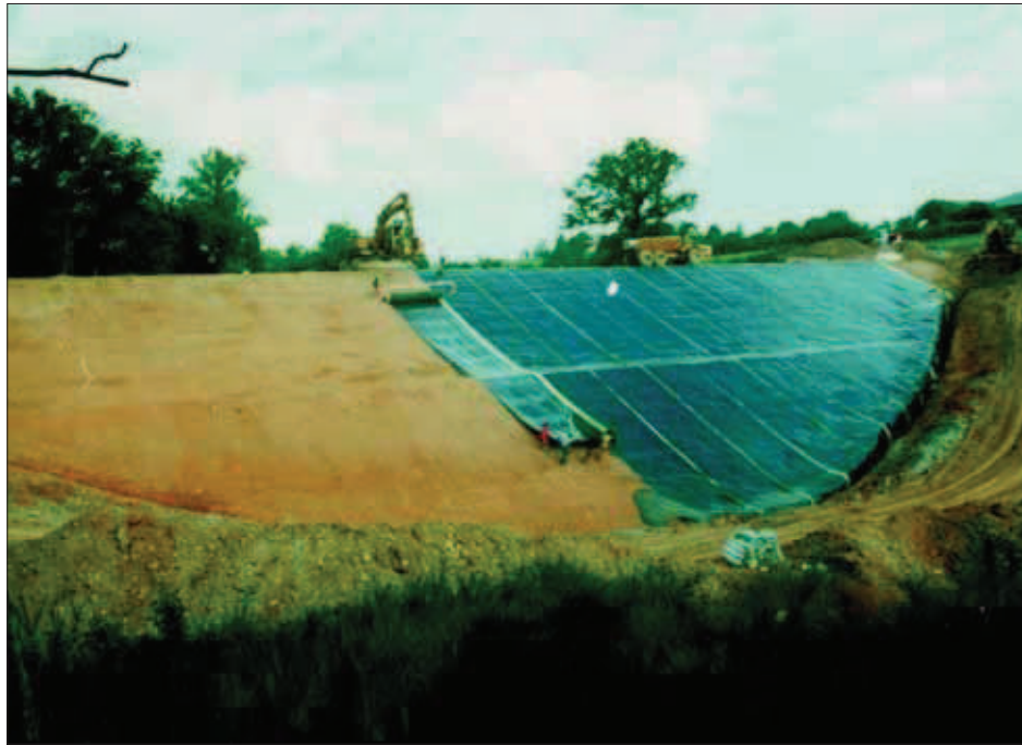
▲ 10 - Placing a bituminous geomembrane. (text p. 81).
