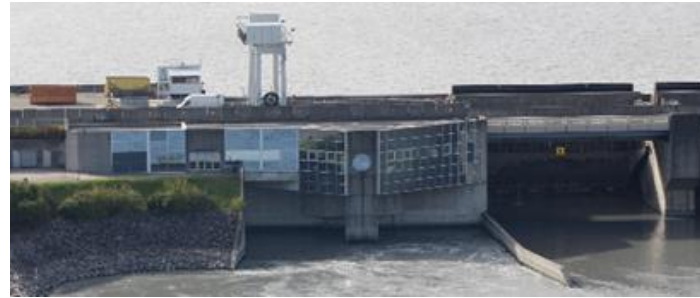
© Photo EDF Usine vue d'aval
