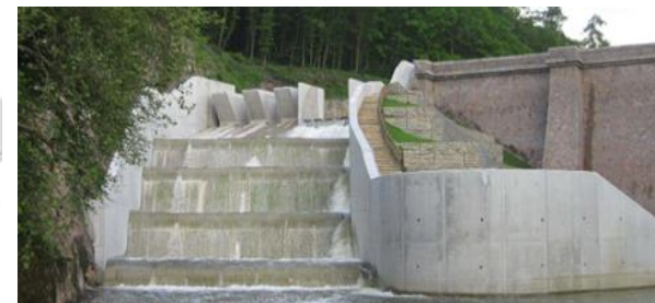
© Photo ISL Vue d'ensemble du barrage avant réhabilitation
