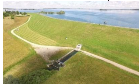
© Photo EPTB SGL barrage de Giffaumont et restitution vers la Droye
