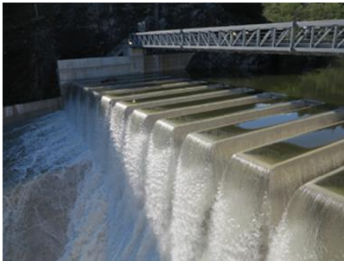
© Photo EDF 1 er déversement du PKW en 2013
