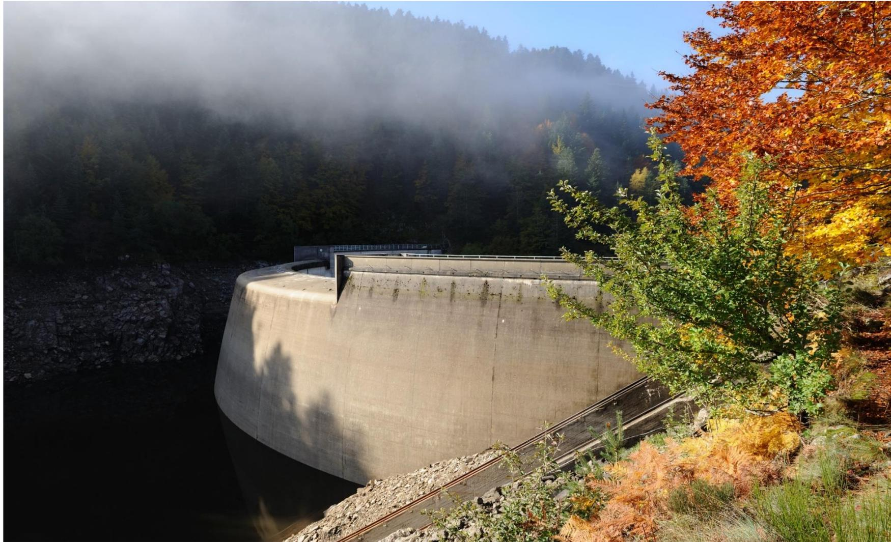
© Photo EDF Evacuateur initial avec arrosage du parement amont pour refroidissement en été
