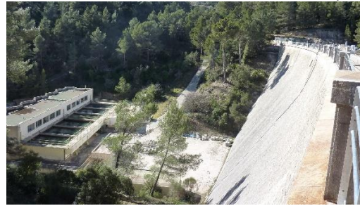
© Photo SCP Parement aval et usine d'eau potable
