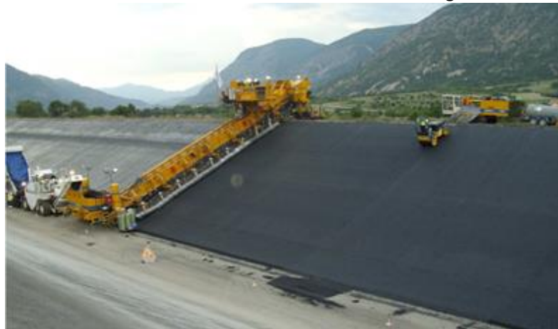
© Photo EDF réhabilitation étanchéité & drainage 2011
