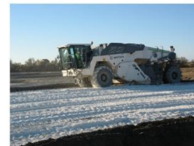
malaxage sur la plate-forme de traitement
