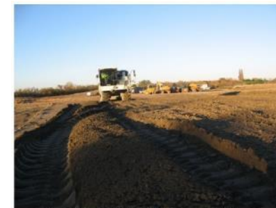
malaxage du sol naturel sur plate-forme avant traitement
