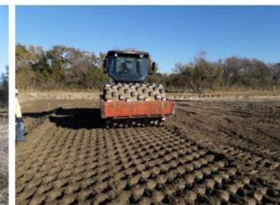
compactage de la couche C1 du plot n°2
