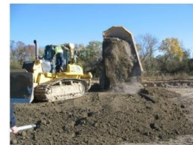
approvisionnement et réglage du sol traité sur le fond de fouille du
