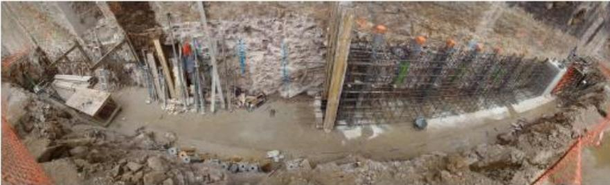
Figure 11 : Cage de ferrailage de la plinthe en zone centrale
