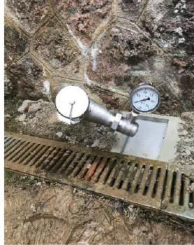
Figure 8 : Equipement provisoire du drain D71 avec manomètre
