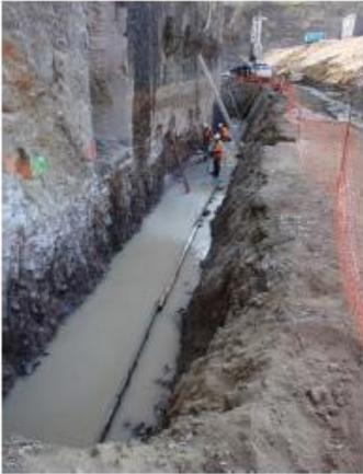
Figure 9 : Contact barrage/fondation dans la partie centrale
