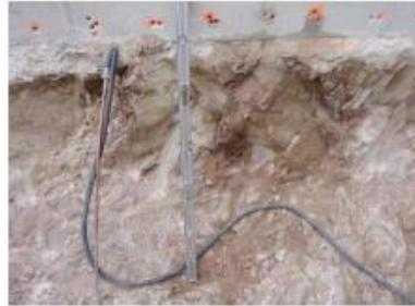
Figure 10 : Contact seuil évacuateur RD /fondation avant réalisation de la plinthe
