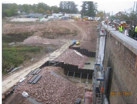
Figure 2 : Dérivation des eaux par la vidange de fond avec dispositif de pompage
