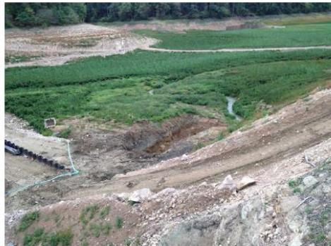
Figure 1 : Dérivation de eaux par la dérivation provisoire en phase d'assec
