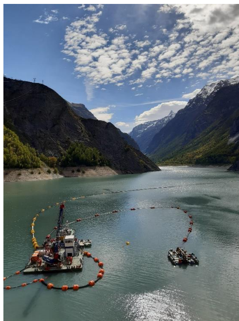
Figure 1 : Drague sur la retenue du Chambon (Copyright EDF HYDRO)
