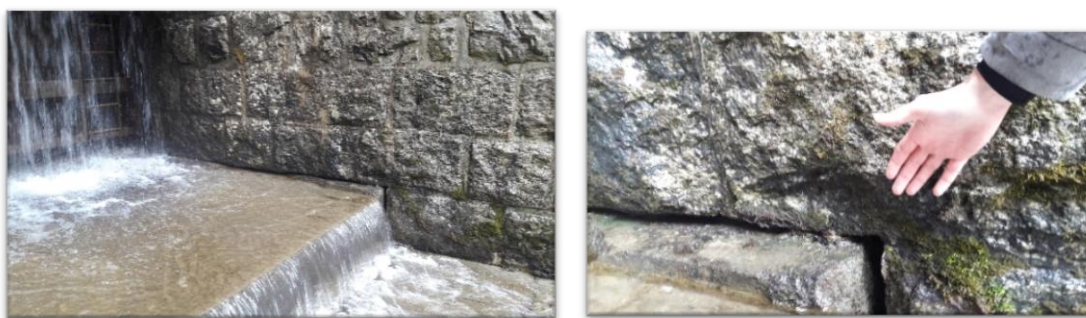
Figure 5 : Cisaillement sous la pile n°3
