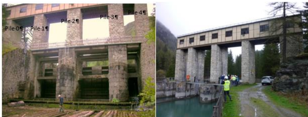
Figure 2 : Photos du barrage vanné (2015) (à gauche vue d'aval, à droite vue d'amont)
