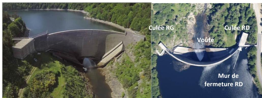
Figure 6 : a) Barrage de la Palisse, vue aval, b) Vue de dessus
