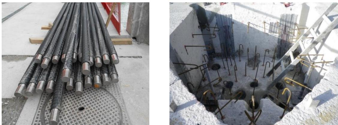
Figure 3 : (a) barres pré-encastées dans leur gaine et (b) vue de dessus d'un avant-bec de pilier équipé de tirants
