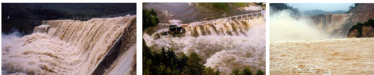
Figure 6 : surverses des barrages de La Rouvière (photo Wikibardig), Chute Garneau [Nguyen, 2011], Ho-Ho (@DTINews)
