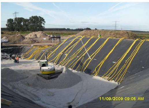
Figure 5 : début de la construction de la digue de l'essai n°2 (photo Deltares)
