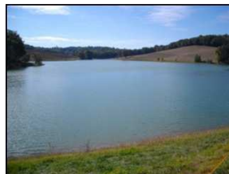
Figure 4 : amont de la digue de Lavit
