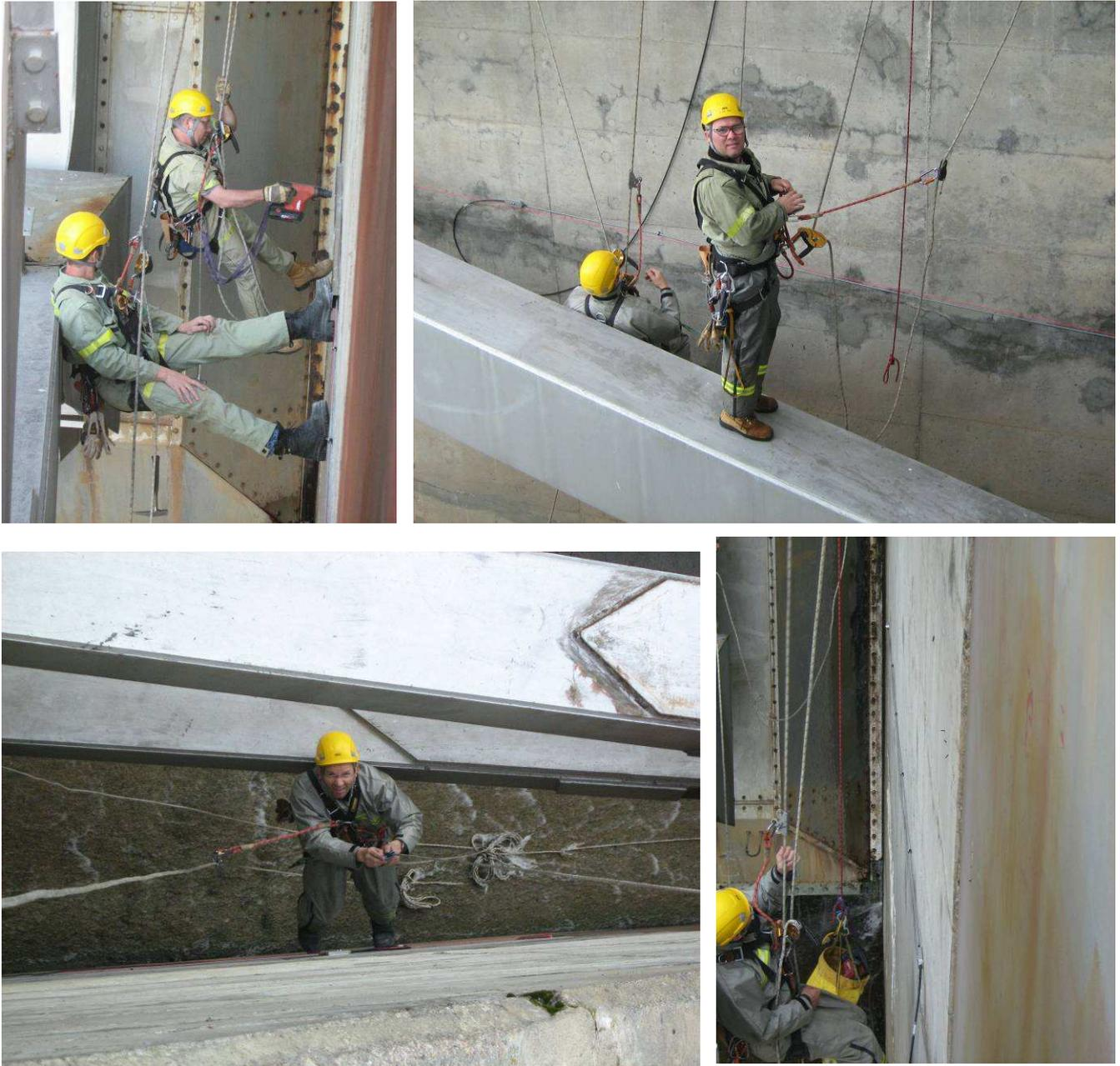
*Figure 8 : Photos de techniciens installant les capteurs.*
