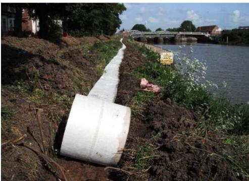
Figure 14 : Déroulage de la bande capteur dans la tranchée inférieure.
