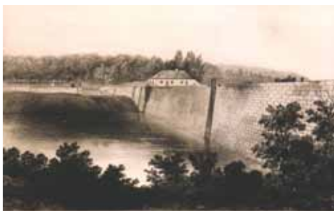
Saloup (1807) dans la forêt de Tronçais - Le barrage est constitué d'un mur au profil trapézoïdal de 13,5 m de haut, buté par un remblai comme à Proserpina. Le bassin versant a une superficie de 11 km 2 . Le lac de 800 000 m 3 est le réservoir de tête du complexe hydraulique des forges de Tronçais. Cet ouvrage tardif s'inscrit dans la tradition des lacs de forge dont il constitue un peu le chant du cygne. ©Inventaire Clermont-Ferrand
