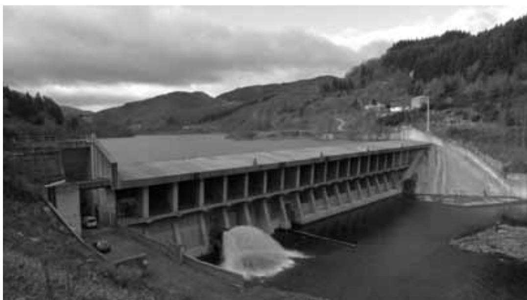
Graphique 1 : Photo du barrage du Cheylard, vue de l'aval
