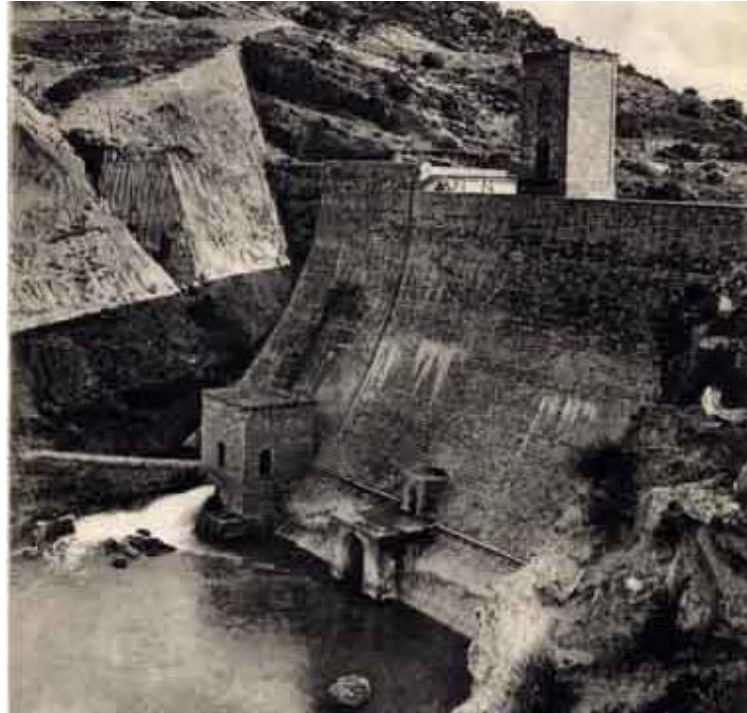
Graphique 3 : Le barrage de Cheurfas, après travaux : nouvel appui RD vers l'amont [17]
