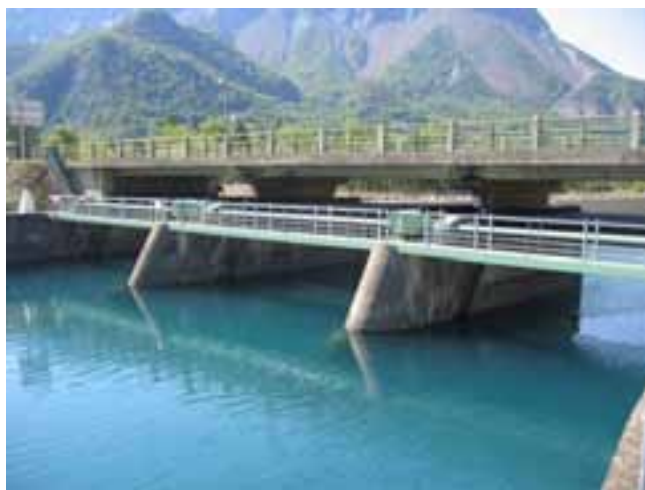
Vannes d'entrée canal ouvertes, vues de la retenue d'Espinasse en amont du canal
