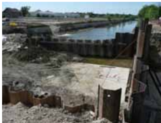
Photos 5 à 9 : Visualisation de la brèche dans le remblai et de l'aqueduc en béton, après réhabilitation (Crédit photos : Guillaume Kiffer, février et mai 2011)
