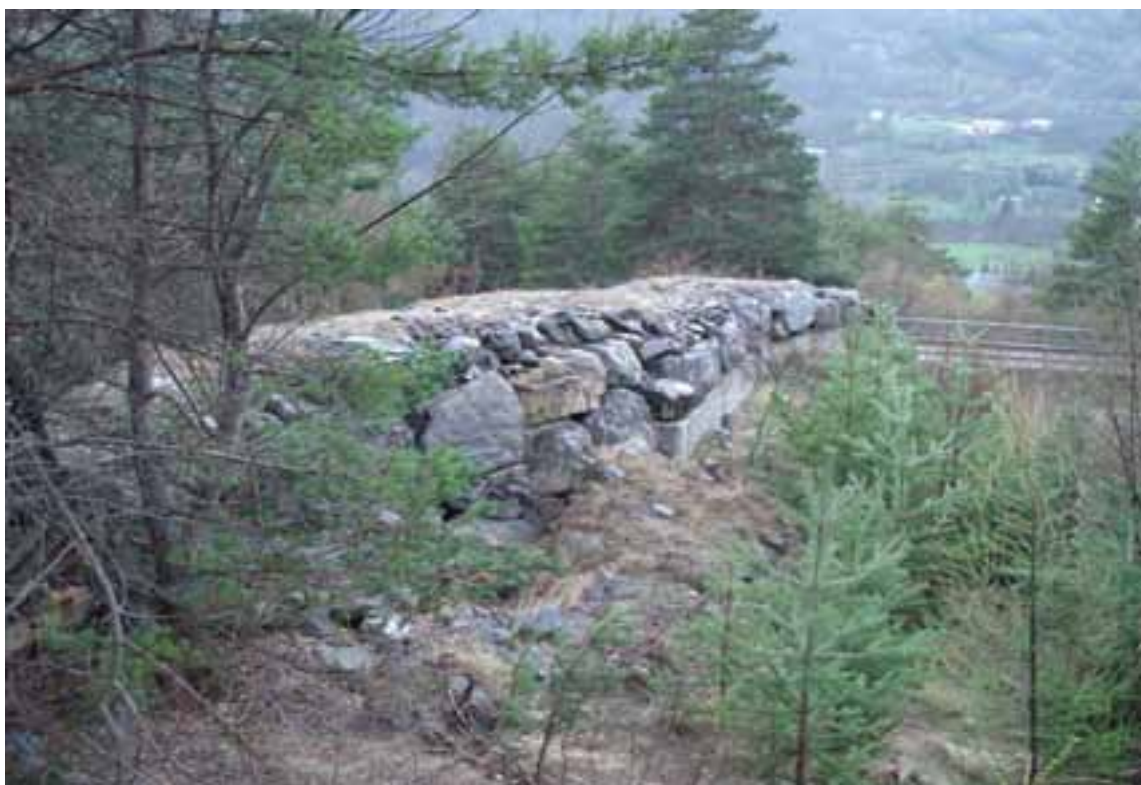
Figure 3 : Tronçon 1-RG entre les barrages B13 et B14, vu depuis l'aile rive droite du barrage B13 (vue amont-aval). La digue est rehaussée (rangée de blocs de béton et enrochements)
