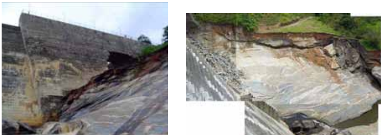
Graphique 11 : Camara - La surface de glissement rive droite ([1])
