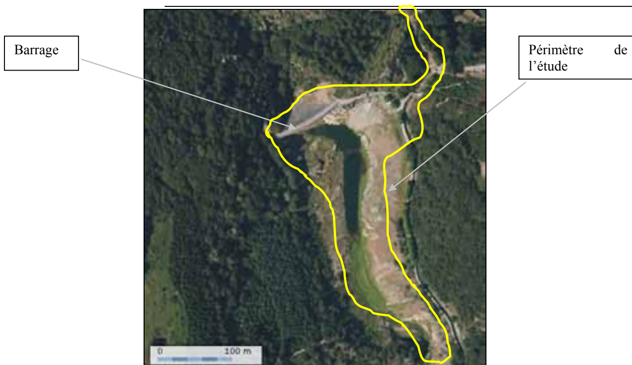
Figure 1 : Vue aérienne du Barrage du Gouffre d'Enfer (Source Geoportail)
