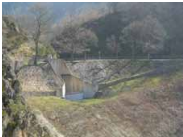
Figure 4 : Photographie de l'évacuateur principal
