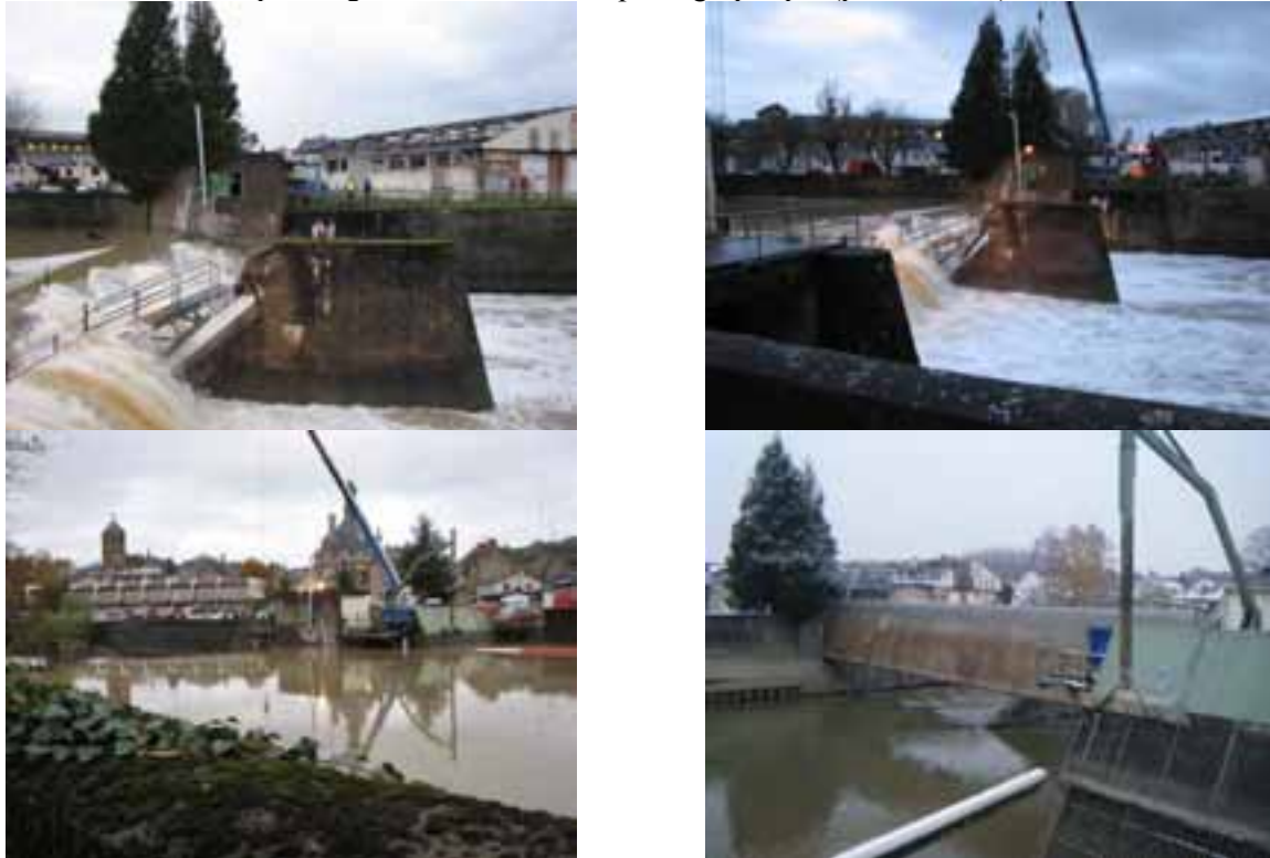
Photos 1 à 4 : Surverse du barrage de Rethel, mise en place des grues pour ouvrir la vanne (09/11/2010) et état de l'aménagement à l'issue de l'intervention (Crédit photos : DREAL Champagne Ardenne)
