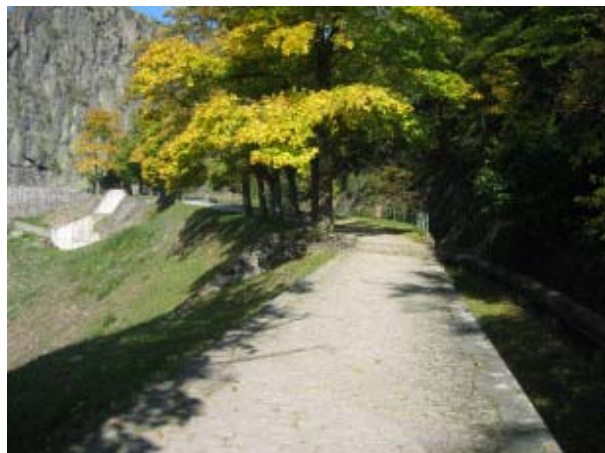
Figure 5 : Photographie de l'évacuateur secondaire
