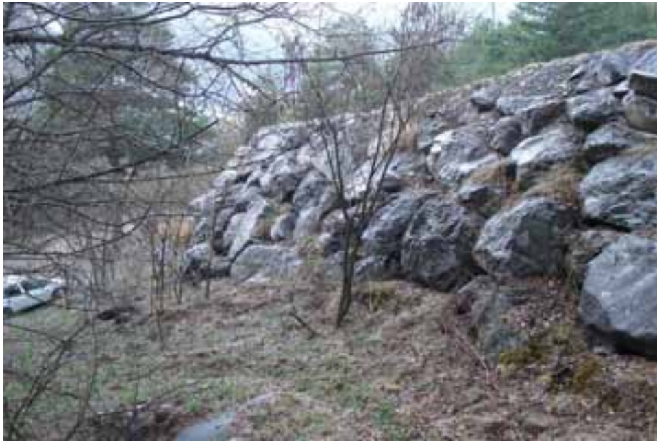
Figure 4 : Parement extérieur enroché du tronçon 1-RG vu depuis son pied (vue amont-aval). Côté milieu extérieur protégé, la hauteur de la digue est importante et atteint 4,5 m par rapport au point le plus bas du terrain naturel. Le parement extérieur de la digue est totalement enroché, avec des blocs de grosse taille.
