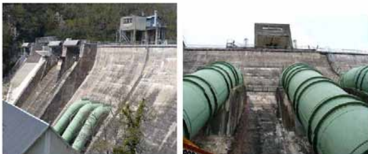
Graphique 1 : cas fréquent d'ouvrages, d'ouvrages à vocation énergétique, potentiellement agresseurs du barrage. Leur défaillance peut générer des pressions dans le corps du barrage. Ils feront l'objet d'un examen technique après vidange, batardage et installation de dispositifs de visite afin de pouvoir évaluer précisément leur état et produire un diagnostic sur leur risque de défaillance.
