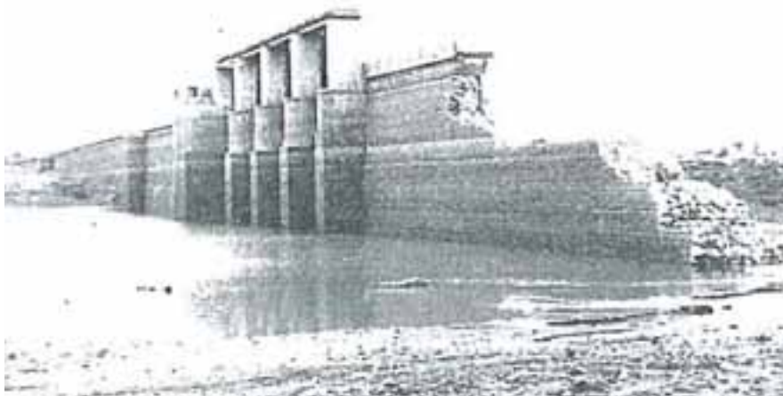
Graphique 17 : Barrage de Chikkahole rompu
