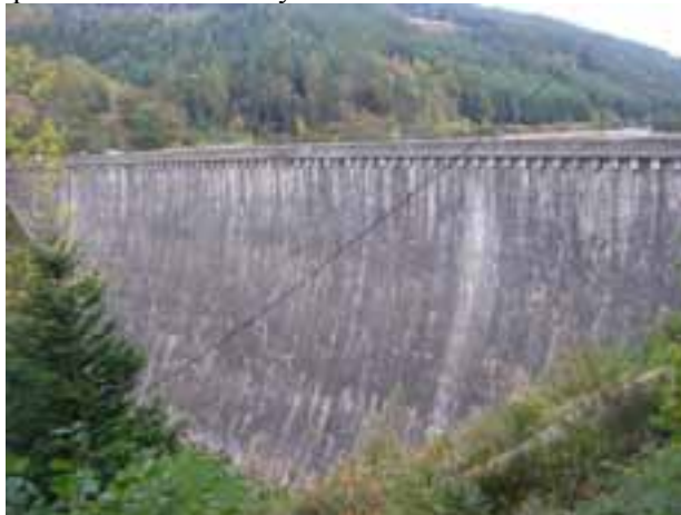
Figure 9 : Parement aval du Barrage du Pas du Riot (Source SAFEGE)
