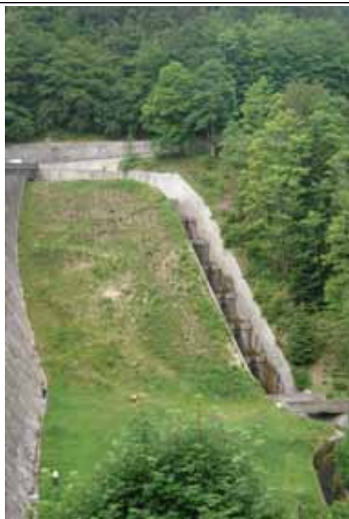
Figure 11 : Coursier de l'évacuateur (Source SAFEGE)
