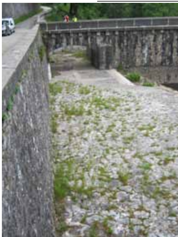
Figure 10 : Seuil de l'évacuateur (Source SAFEGE)
