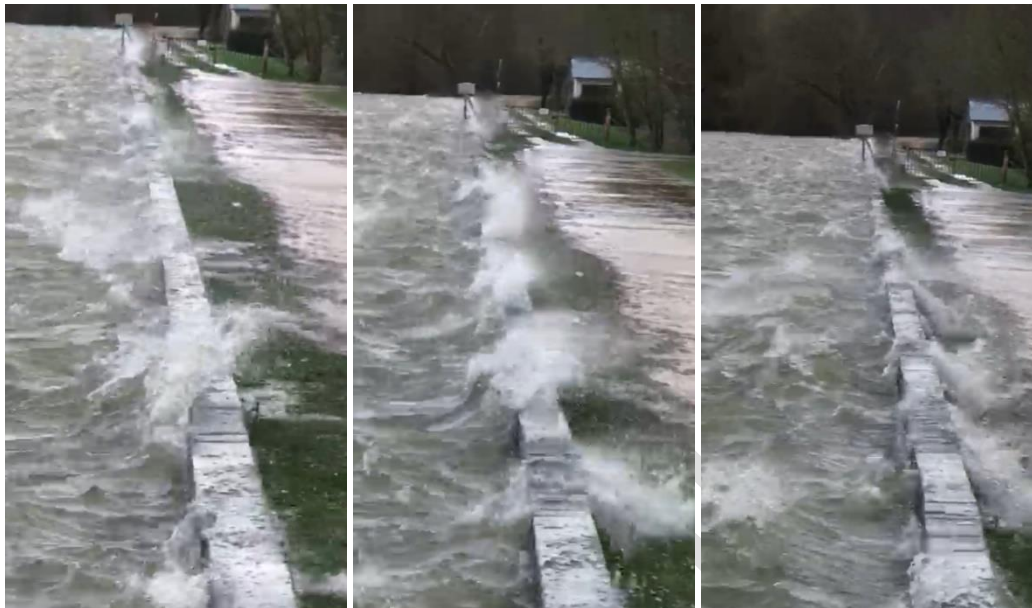
Figure 3 : extrait de vidéo – vagues sur la Seine, sur la commune d'Hénouville, lors de la tempête de février 2020. Le muret fait environ 50-60 cm de haut. Ces franchissements n'ont pas occasionné de dommages sur la digue. Les débits de franchissement sont estimés de 5 à 10 l/s/ml.
