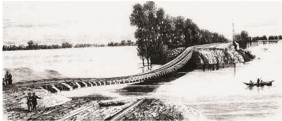
Brèche en aval de Saumur dans la digue de l'Authion lors des inondations de septembre-octobre 1866
