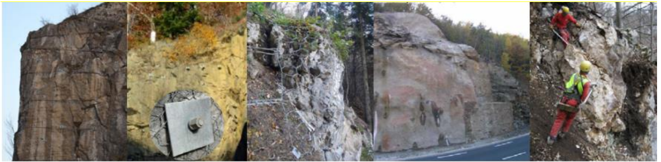
Figure 4 : Parades actives : Emmaitotage câble (©Parn) ; Ancrages(©Parn) ; Filet plaqué (© CD73) ; Béton projeté (Cerema) ; Purge (© Cerema)
