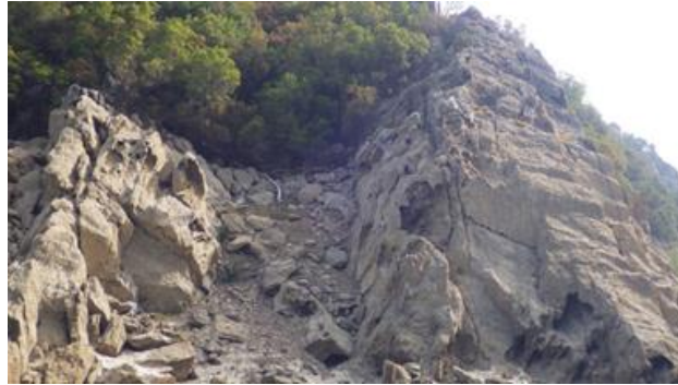
Figure 4 : Falaise surplombant la retenue en amont immédiat du barrage en rive droite
