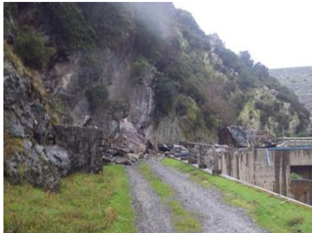
Figure 2 - Chute de blocs intervenue en janvier 2023 sur la piste rive droite au-dessus de la sortie de l'évacuateur de crues
