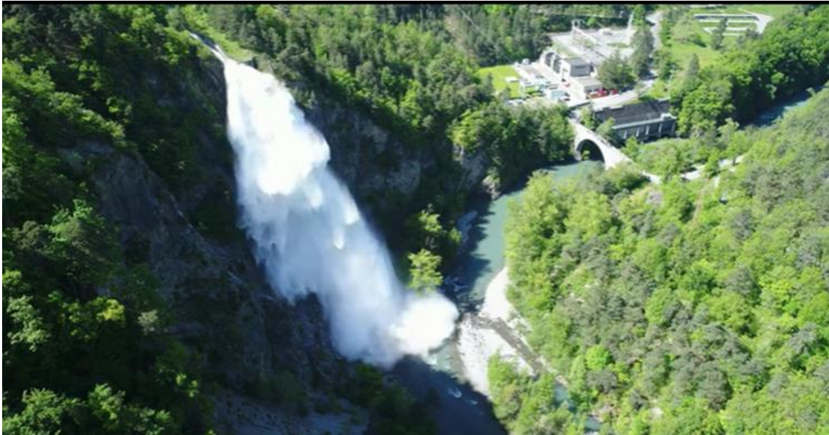
Figure 2 : Essai de déversement à la Cheminée d'équilibre de Saint Pierre de Cognet réalisé le 23/05/2019 par EDF Hydro Exploitation Ecrins Vercors en présence de représentants de la Fédération de Pêche de l'Isère, d'AAPPMA locales, de la Fédération Nationale de Canoë Kayak, de pompiers et de gendarmes.
