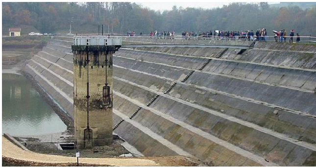
Figure 9 – vue du parement amont - vidange de 2001
