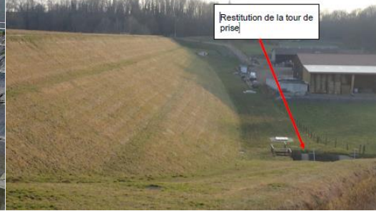
vue du parement aval (©VNF/DIMOA)
