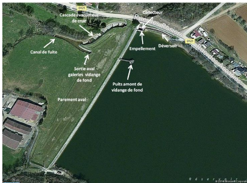
Figure 8- vue aérienne du barrage et de ses organes (©ISL)
