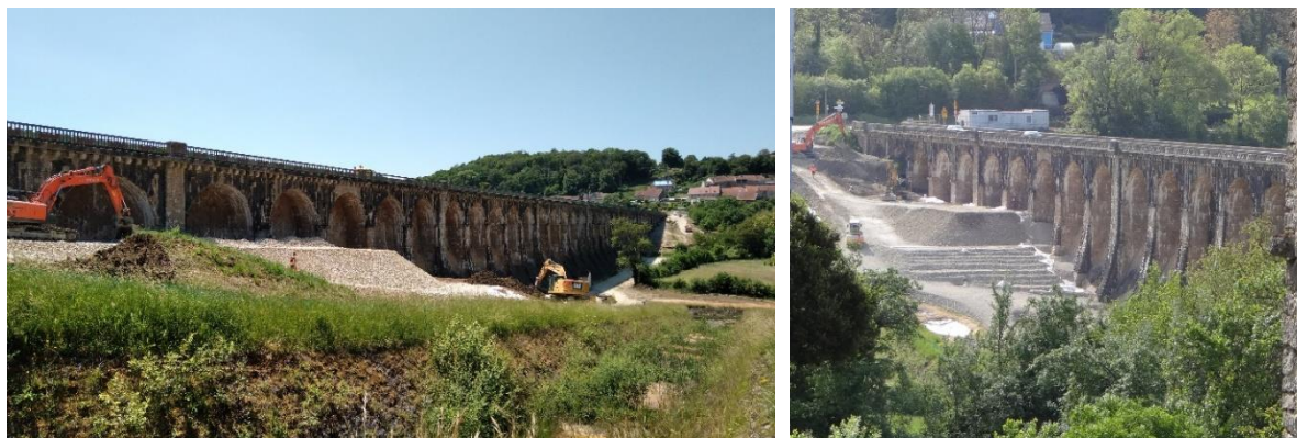
Figure 6- Quelques photos des travaux (@VNF/DIMOA)
