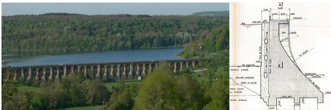
Figure 1 - Vue générale amont + coupe transversale (partie centrale, avec masque Levy) (©VNF/DIMOA)
