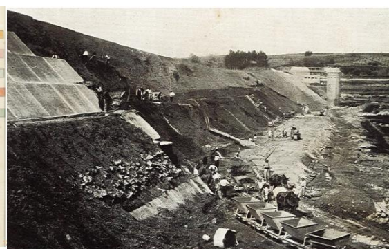
Figure 22 : état d'avancement des travaux en août 1910 (source : 1.5.2)
