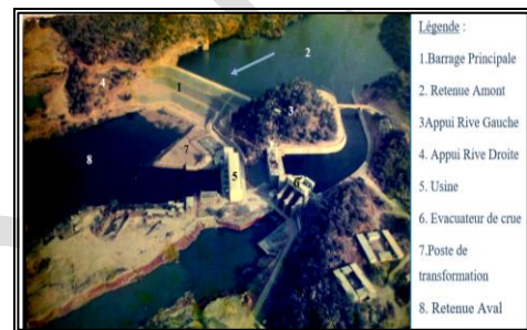
Figure 3 : Vue Aérienne du barrage de Lagdo et ses ouvrages connexes
