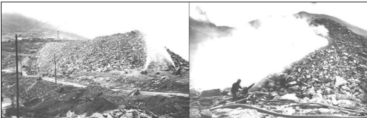
Figure 8 : Mise en place des enrochements par arrosage (Extrait du rapport de mi-chantier de 1957).
