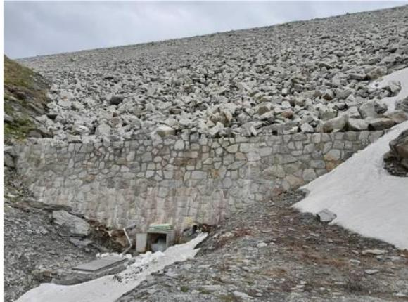
Figure 9 : Vue générale du parement aval et du mur de pied aval.
