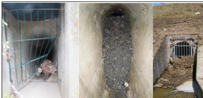
Figure 7 - Embâcles et transport solide dans les ovoïdes
