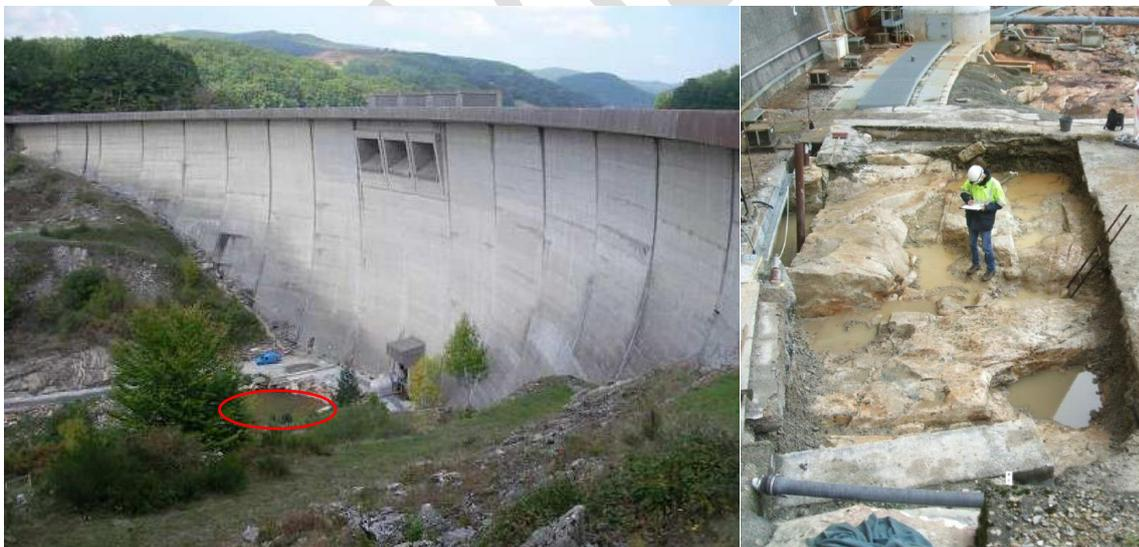
Figure 7: vue aval du barrage avec la fosse de dissipation en rouge (gauche) et détail du confortement de pied aval (droite)
