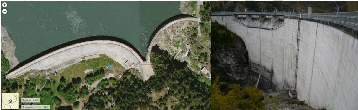
Figure 10 - Vue satellite (@Géoportail) du barrage et vue aval des seuils déversants de l'EVC sur le barrage-voûte
