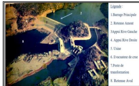
Figure 3 : Vue Aérienne du barrage de Lagdo et ses ouvrages connexes
