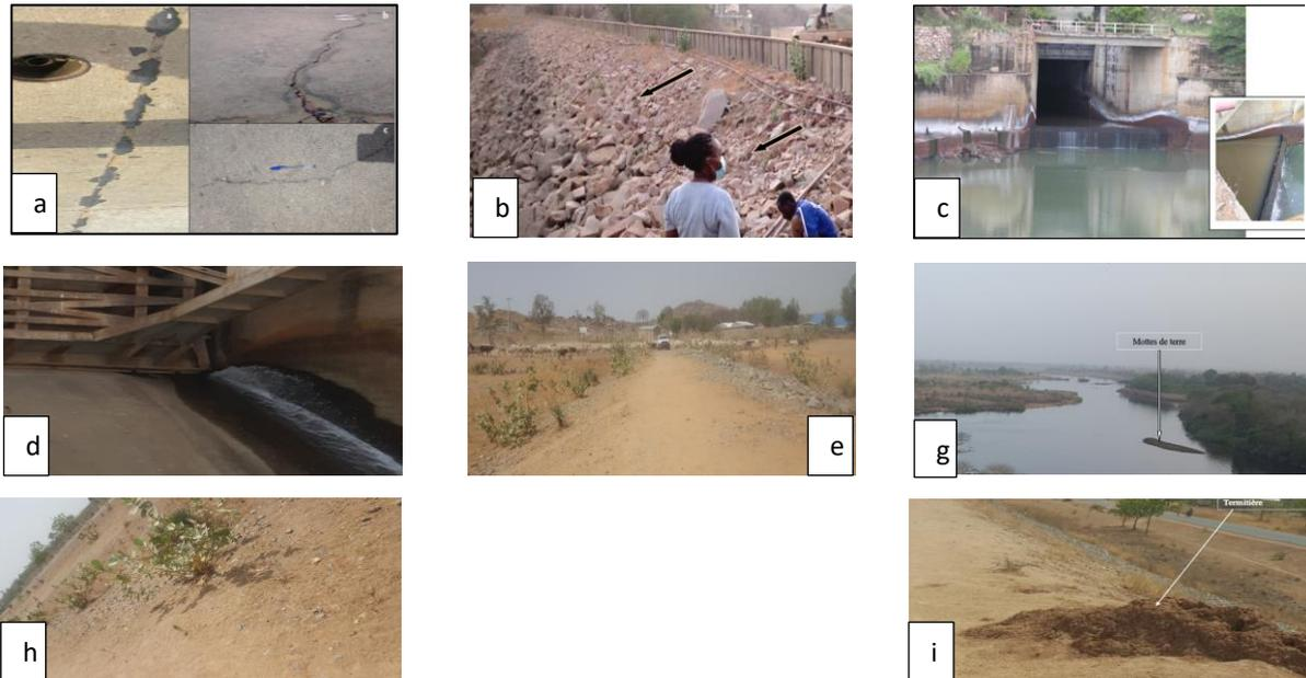
Figure 4 : Illustration des désordres observés sur les parties d'ouvrage. a) Fissures transversales de crête, b) Dégradation de talus avec ségrégation des enrochements, c) Détérioration du béton par efflorescence d) Fuite d'eau à travers les clapets de vanne, e) Point bas sur la crête et érosion anthropique, g) Sédimentation retenue aval, h) Développement de la végétation et dégradation du talus, i) Termitières
