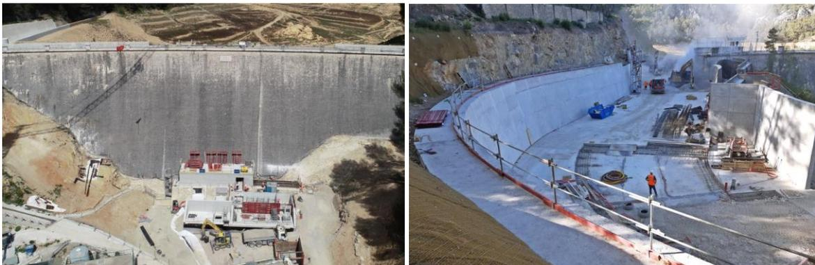
Figure 1 : Vue aval avant recharge aval (à gauche) et vue des travaux d'élargissement de l'évacuateur de crues (à droite)
