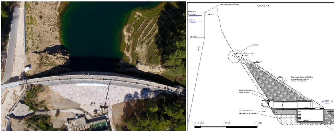
Figure 2 : Vue du barrage après confortement et coupe de la recharge aval et chambre de vannes
