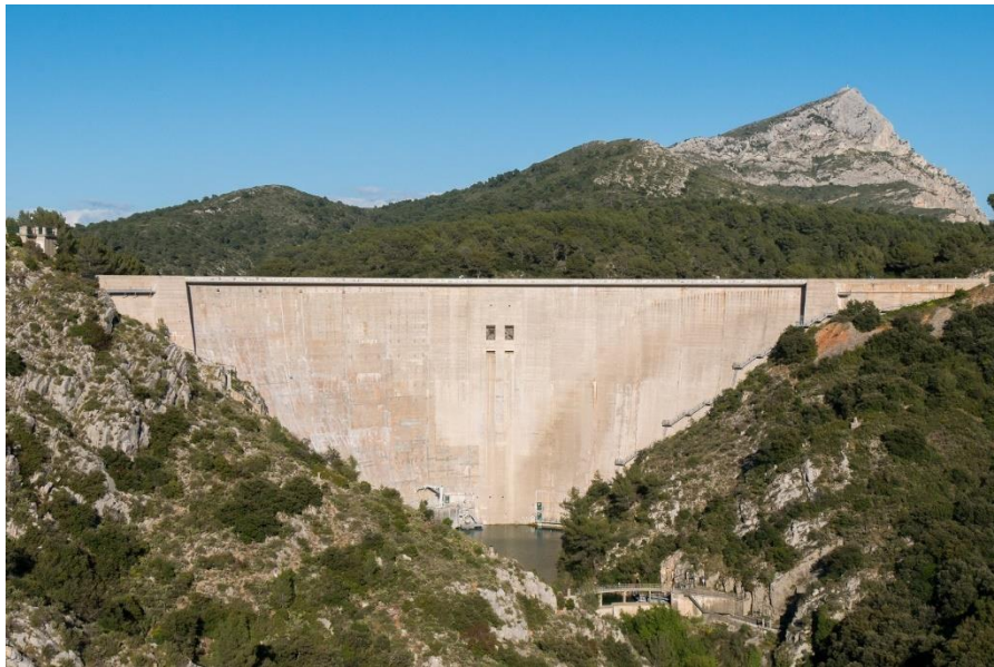
Figure 1 : le barrage de Bimont
