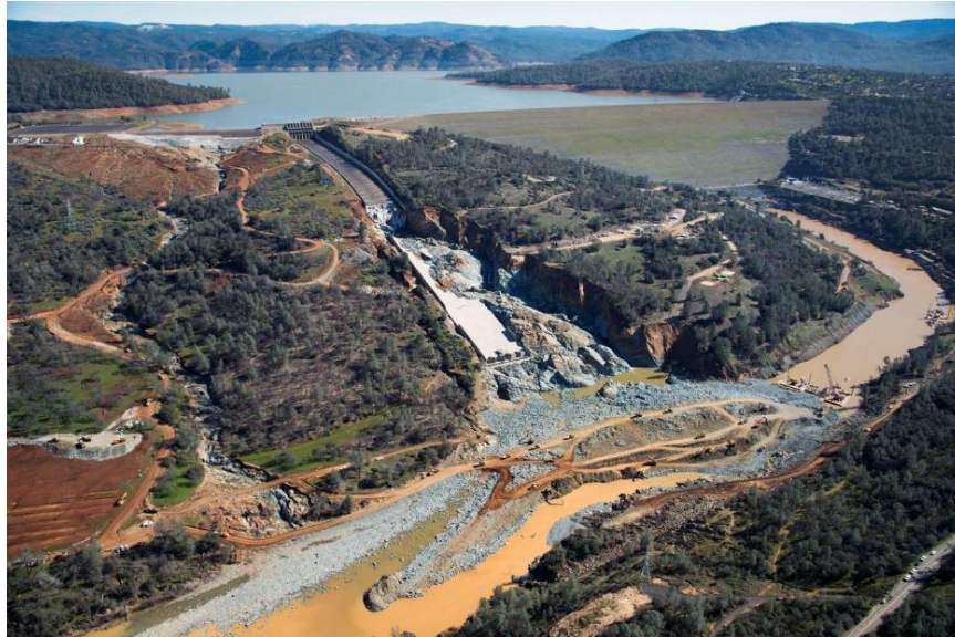
Figure 6 : Exemple de défaillance hydraulique – Barrage d'Oroville (USA) – Février 2017 – Défaillance des EVCs
