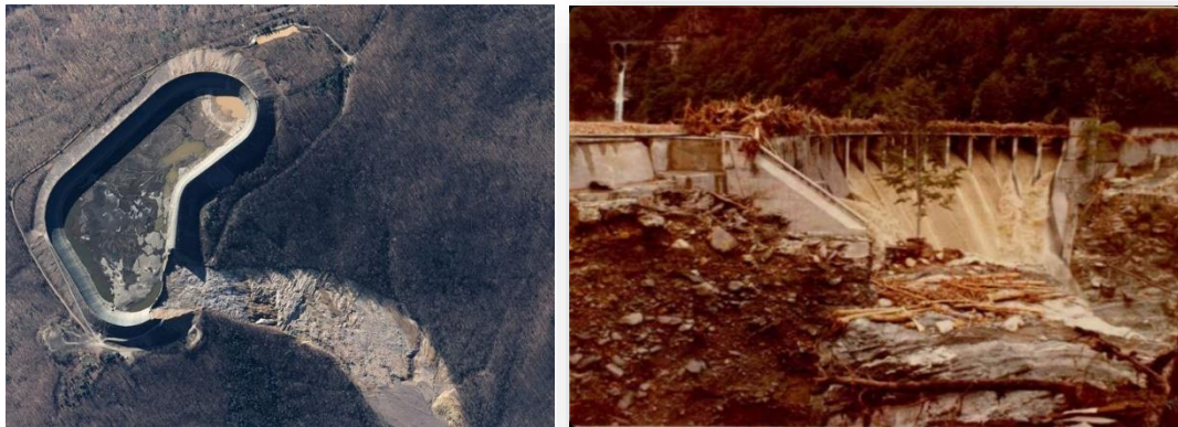
Figure 7 : Atteinte de la cote de danger
