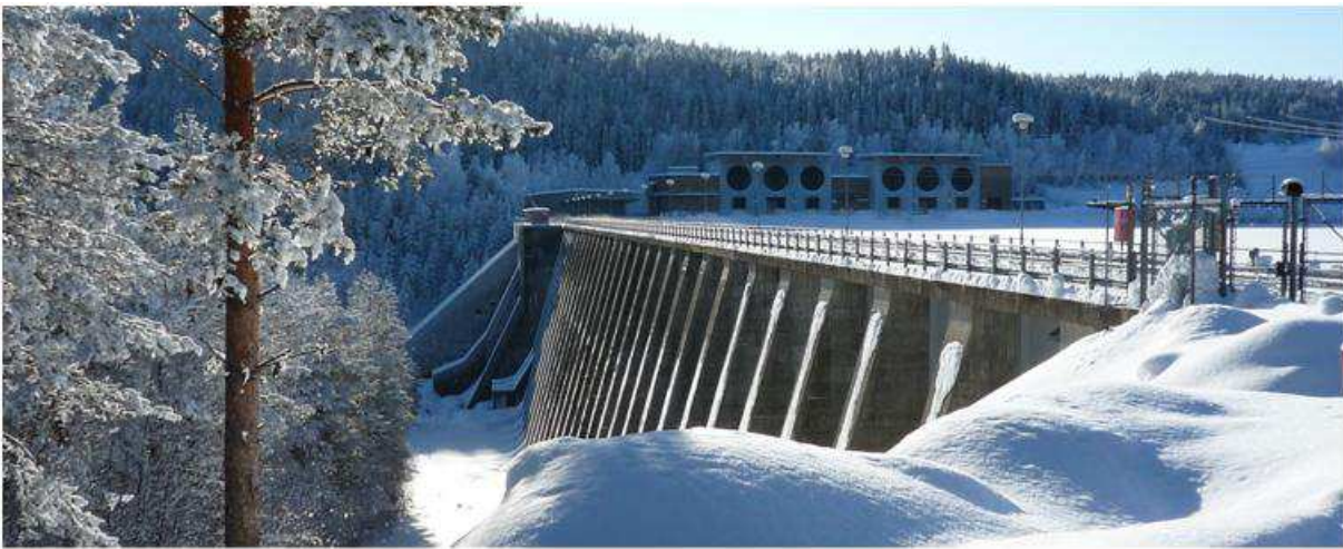
Figure 3: Photo du barrage hydroélectrique de Ramsele Photo: Jonas Andrén
