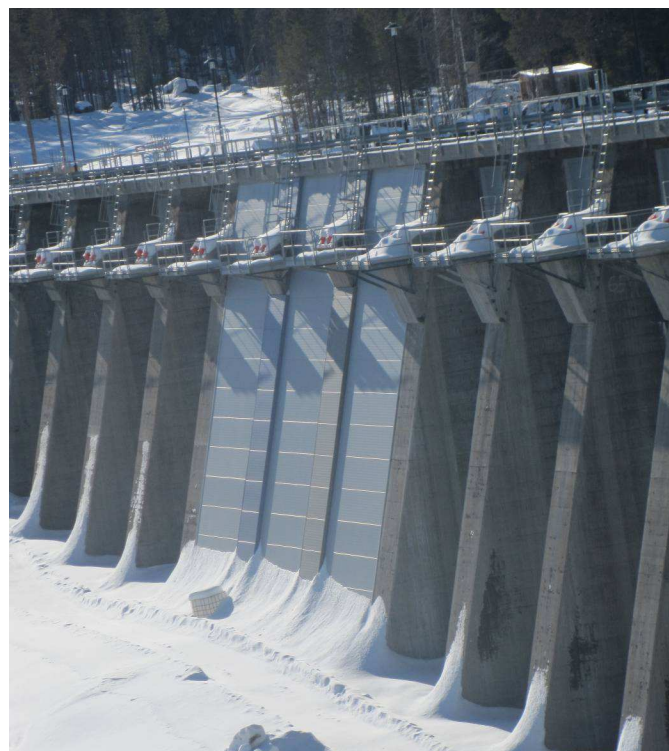
Figure 17: Nouvelle installation des parois isolantes. Photo: Richard Malm
