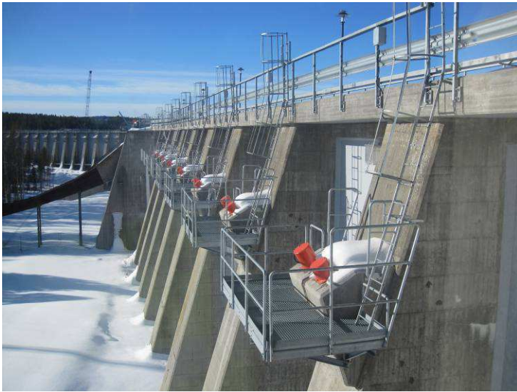
Figure 16: Tirants installés pour améliorer la stabilité du barrage. Photo: Richard Malm.
