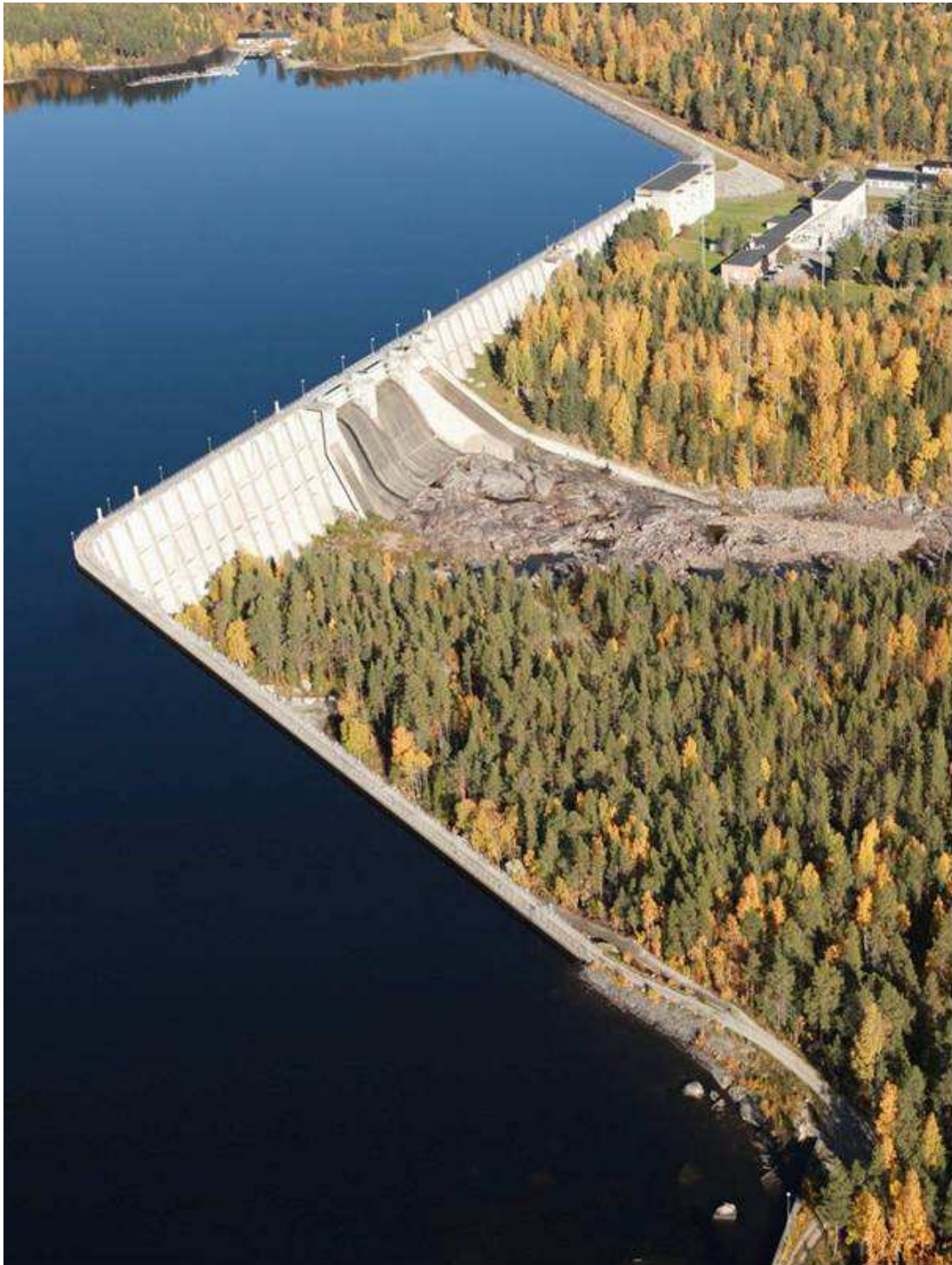
Figure 2: Photo du barrage hydroélectrique de Storfinnforsen.
