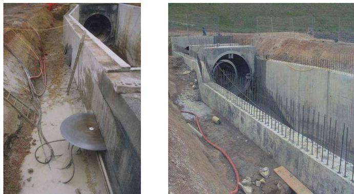
*Photo 1 : Reprise au droit des voiles : Découpage et Scellement des attentes*
