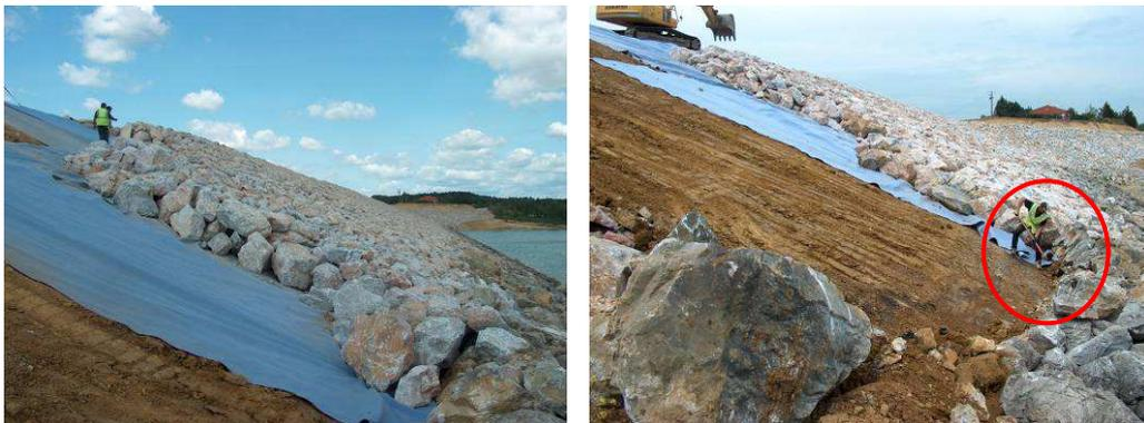
Photo 5 : Protection amont en enrochement : Pose sur géotextile et nettoyages manuel du raccordement
