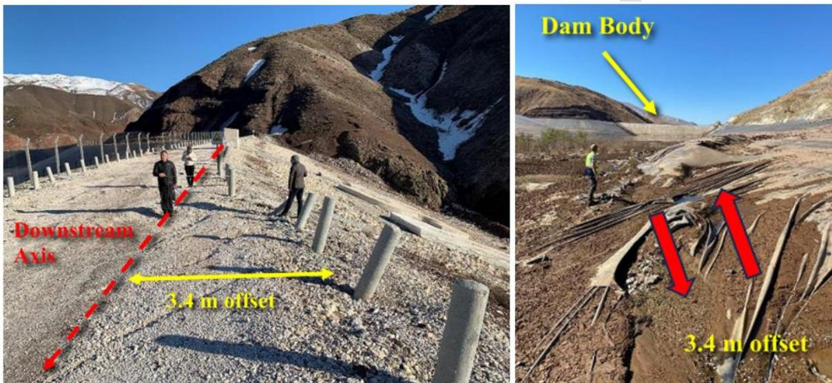
Figure 10 - Cisaillement de la crête du barrage – cisaillement et dégradation de la membrane dans la retenue [21]
