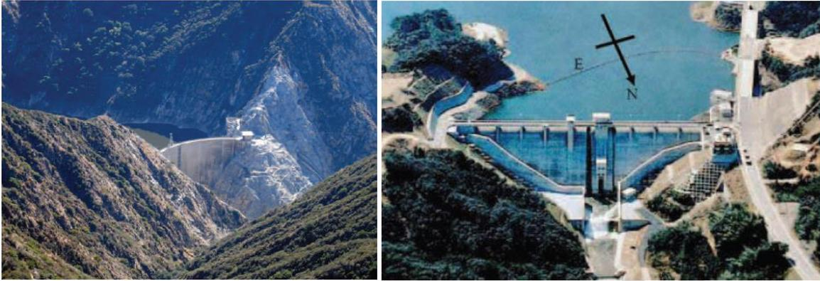
Figure 19 – Barrage voûte de Pacoima (à droite, USA) et barrage poids de Kasho (à gauche, Japon) qui ont tous deux connus des accélérations en crête > 2 g selon Nuss [13]
