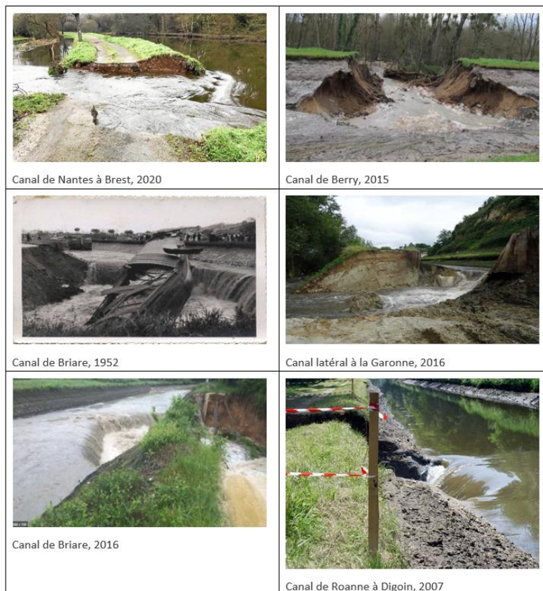
Figure 5 : Accidentologie sur les canaux, photos de brèches (source : ERINOH [5] et VNF)
