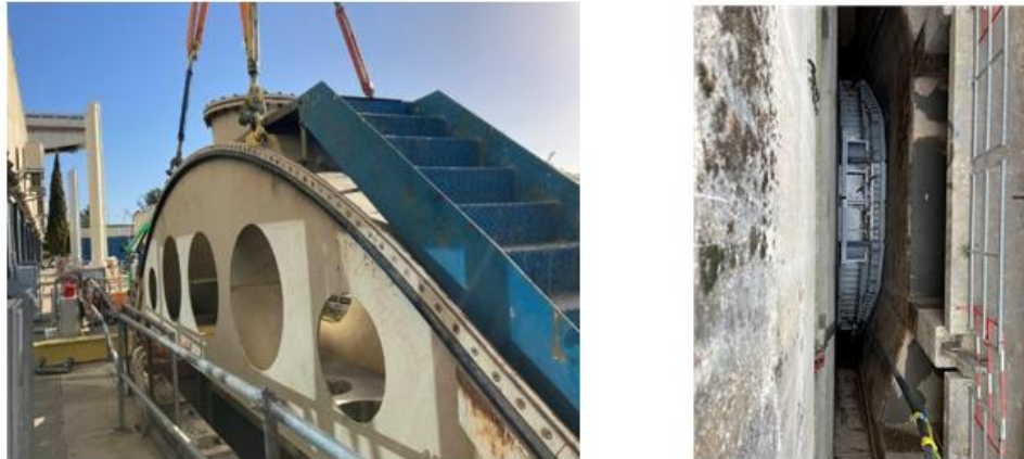
Figure 9 : Mise en place du batardeau-puits à l'aide du portique de l'aménagement
