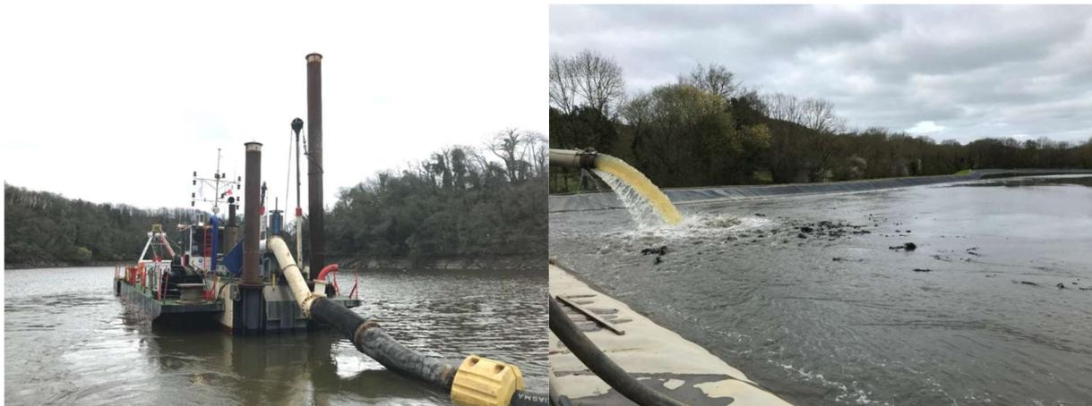
Figure 9 : Dragage de la retenue et refoulement hydraulique dans les bassins de décantation (mars 2024)
