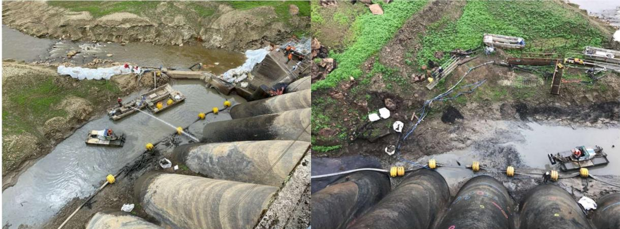
Figure 10 : Travaux de purge en pied du parement amont (juin 2024)
