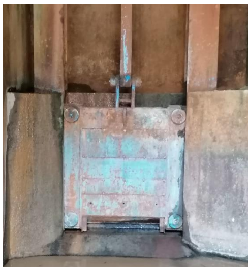
Figure 11 : Vanne de vidange le jour de l'examen exhaustif (29/11/21)
