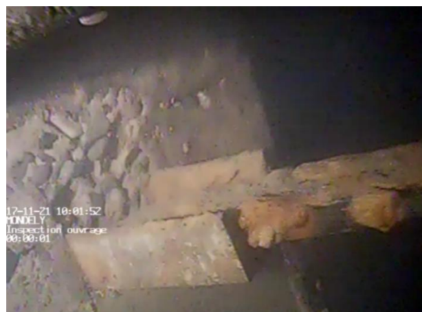
Figure 2 : Inspection de la prise d’eau du barrage de Mondély (09)
