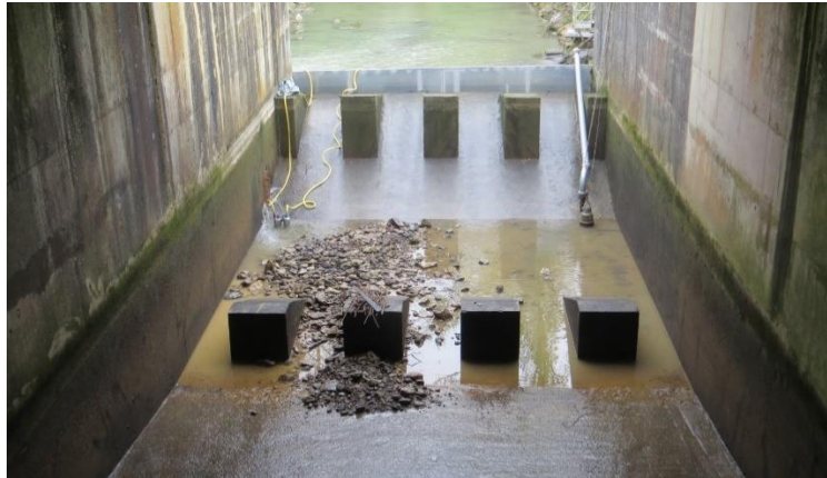
Figure 9 : Batardeau de la galerie d'évacuation des crues du barrage de Puydarrieux
