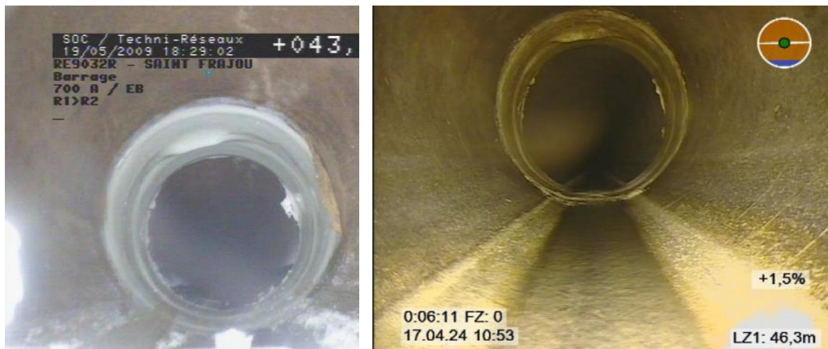
Figure 10 : Photographies du chemisage de la conduite d'Aussou (2009 – 2024)
