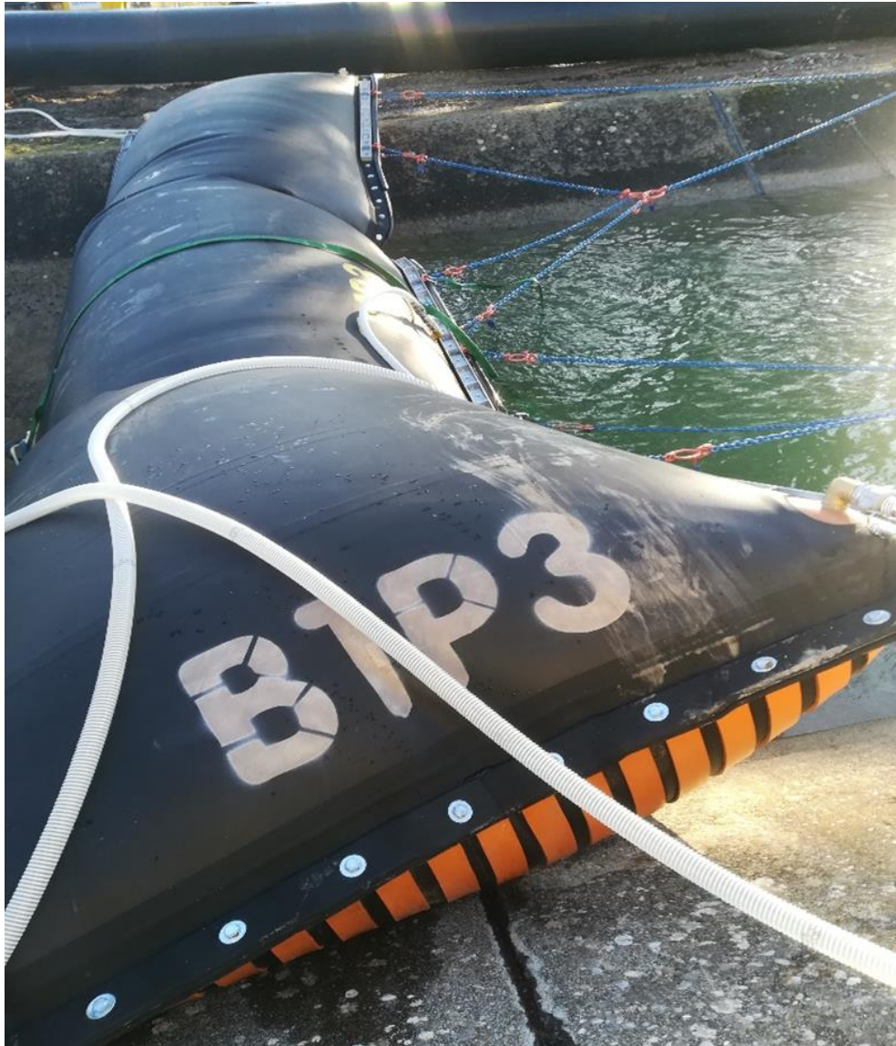
Figure 5 - Batardeau vu depuis la berge
