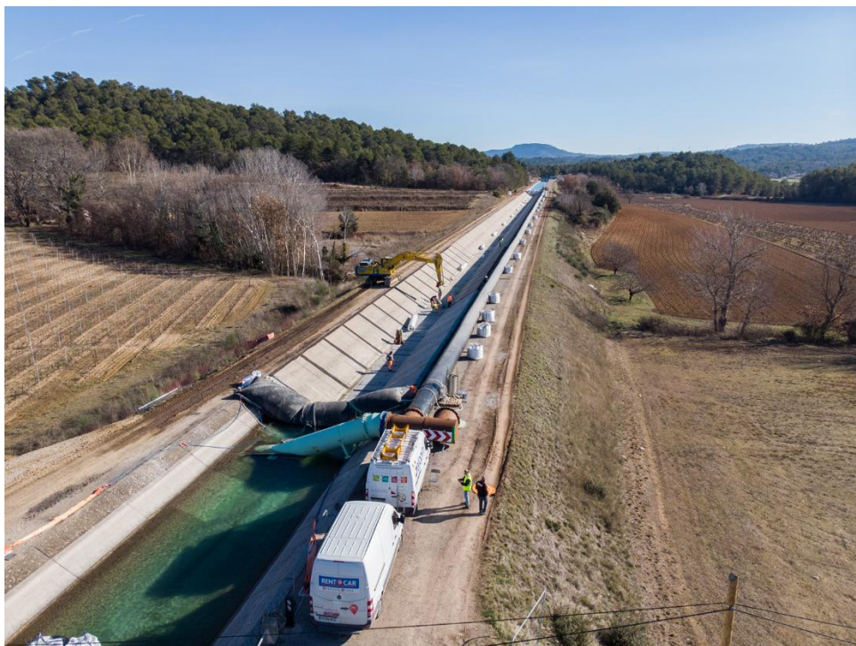
Figure 7 - Bief batardé vue aérienne
