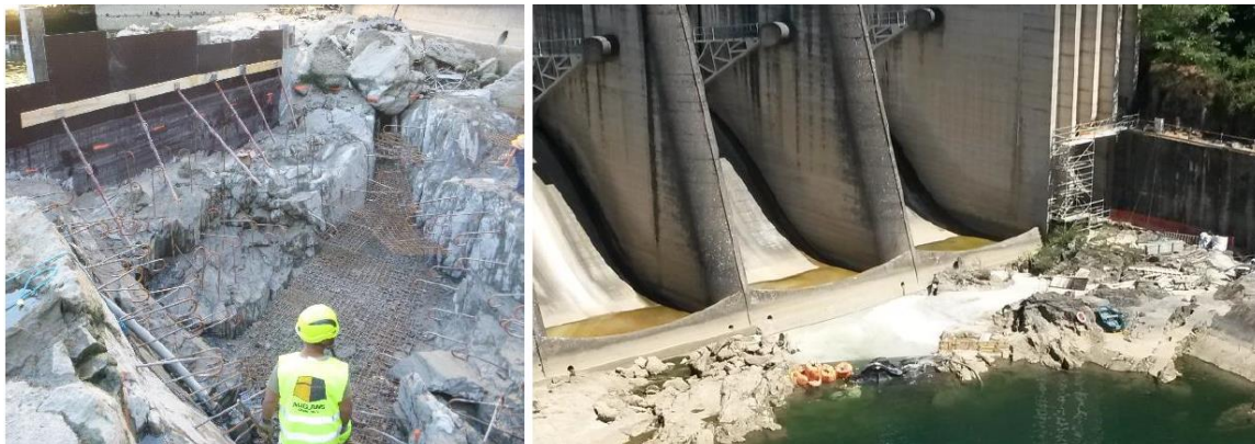
Figure 16 : Travaux de réparation d'une zone érodée à l'aval des passes 1 et 2 en 2016
