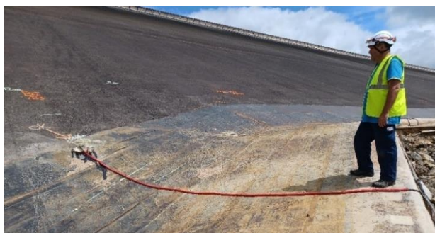
Figure 4 : Installation de nouvelles cellules piézométriques en vidange sous le masque amont d'un remblai (Montézic)
