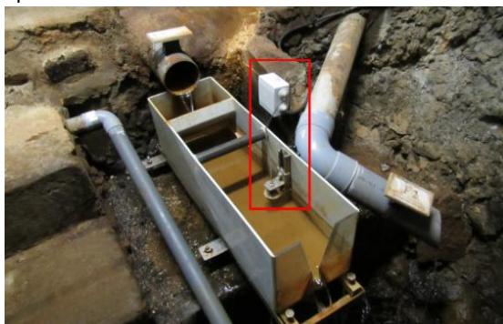
Figure 3 : Installation d'un dispositif d'alarme sur dépassement de débit de fuite suite analyse de la pertinence du dispositif et préconisations dans le rapport d'auscultation de Gréoux [7]
