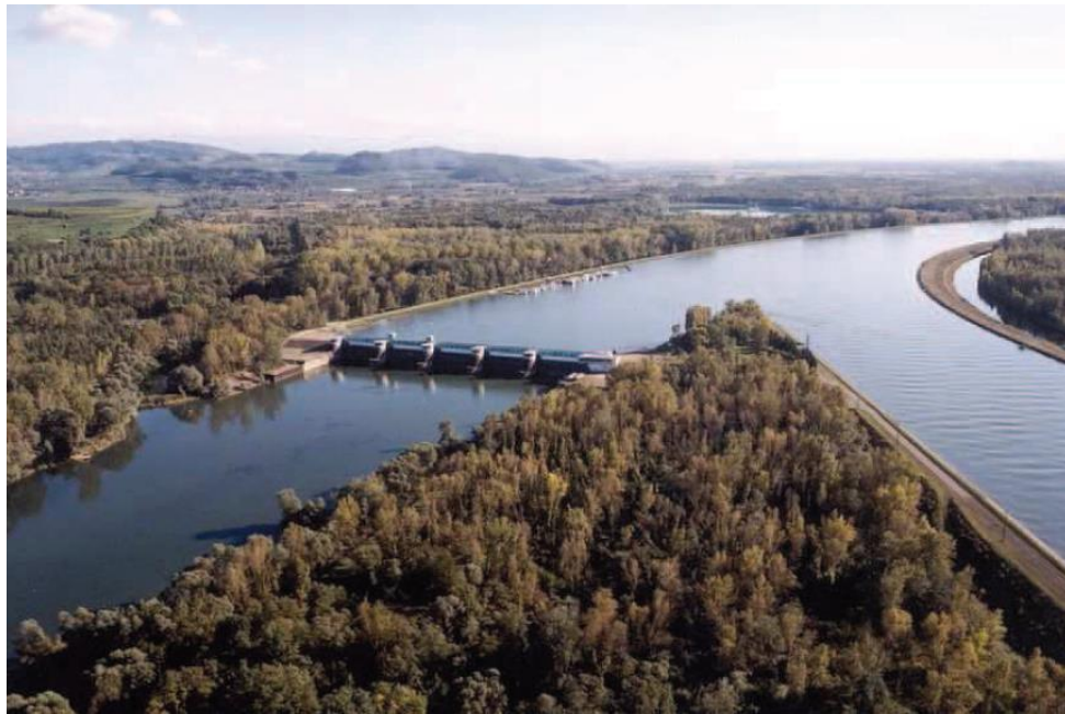
Figure 2 : Vue aérienne du barrage de Marckolsheim
