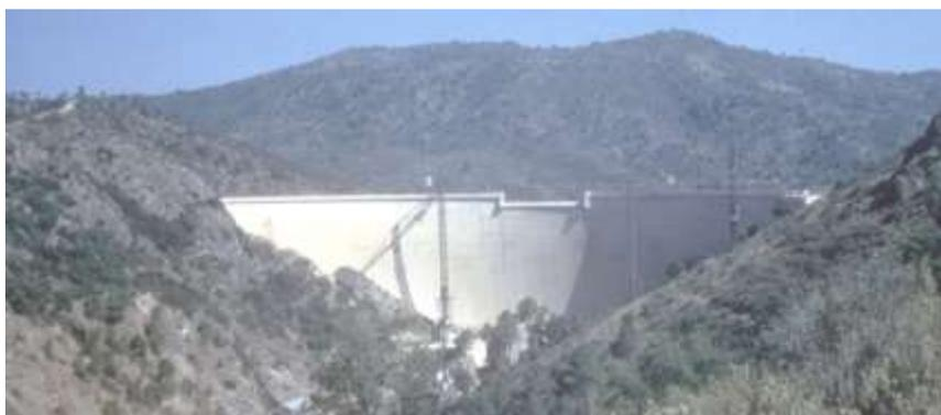
*Fig. 2* Vue d'aval du barrage de Malpasset à la fin de sa construction : la culée apparaît à droite (en rive gauche), le déversoir de crues à seuil libre au centre (photo ACJB, été 1954).
