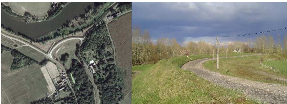
Ci-dessus : déversoir du Bec de Cher à rehausse fusible en extrémité de crête côté Cher, avec armure de pavés sur la crête déversante et digues de canalisation des eaux déversées vers l'aval (à gauche : photographie aérienne IGN, à droite : photographie D. GOUTX)
