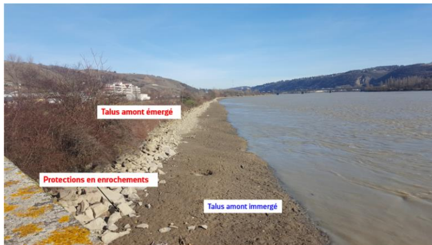
Figure 1 : Photographie du parement amont du barrage latéral rive droite de l'aménagement de Vaugris à plan d'eau bas
