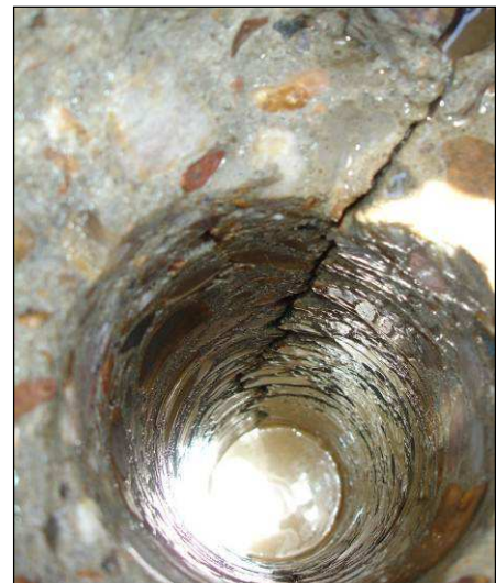
Position (en rouge) et aspect des fissures identifiées
