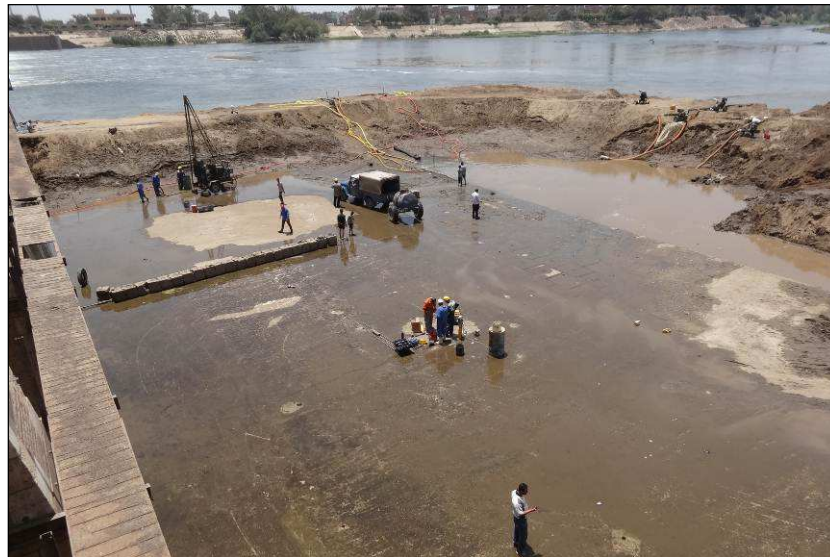
Mis à sec du batardeau et démarrage des sondages dans les fissures
