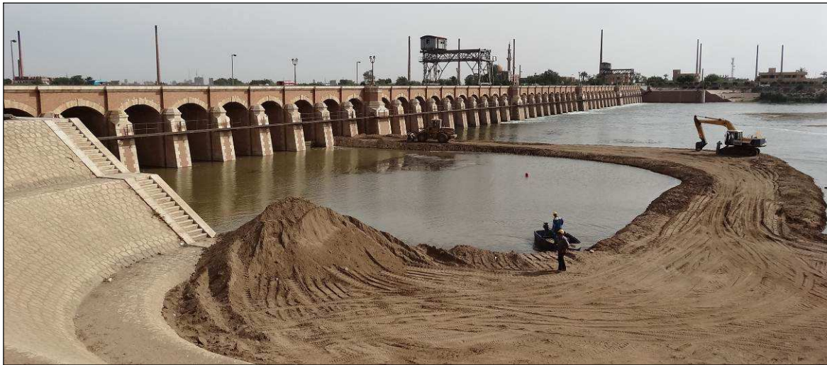
Construction du batardeau – vue depuis la rive droite
