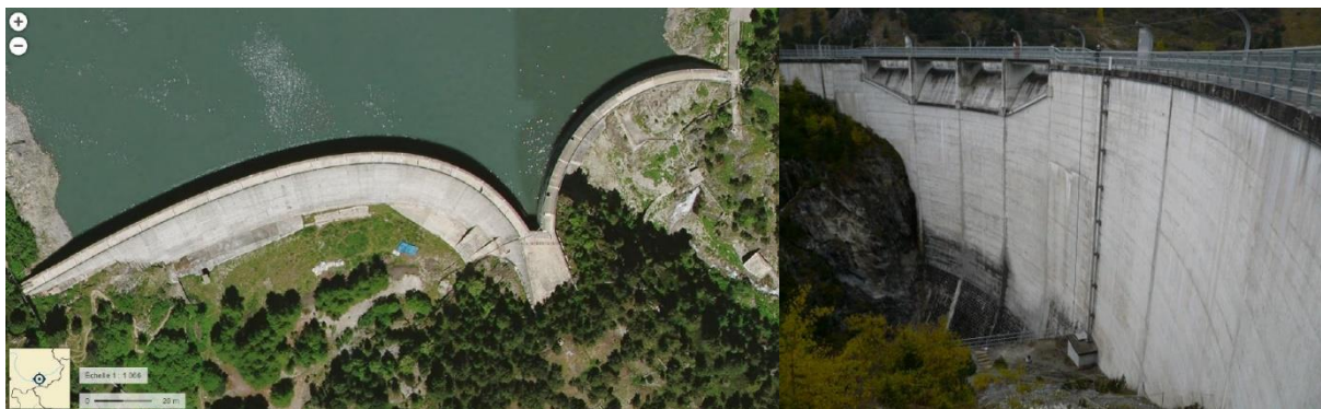
Figure 10 - Vue satellite (@Géoportail) du barrage et vue aval des seuils déversants de l'EVC sur le barrage-voûte
