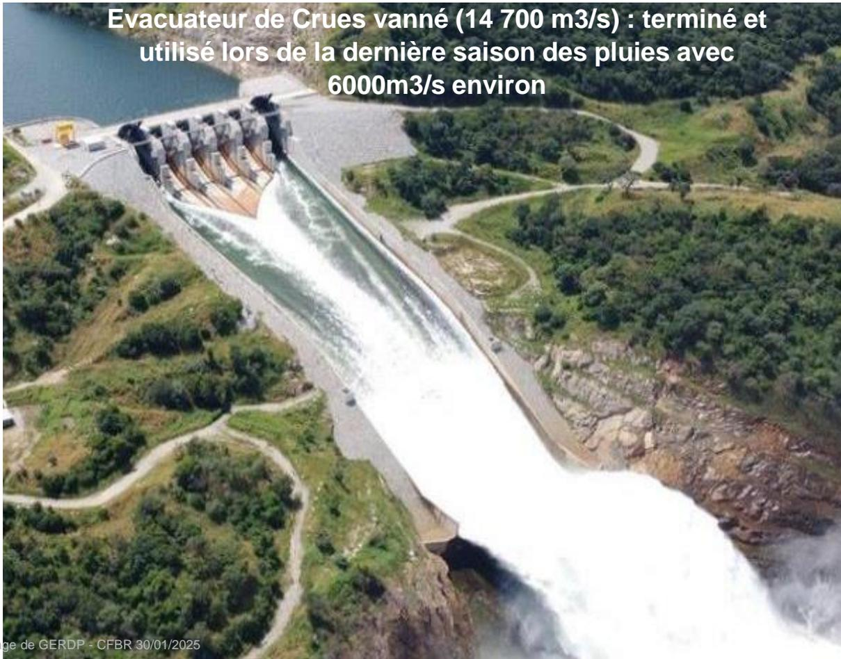
Evacuateur de Crues vanné (14 700 m<sup>3</sup>/s) : terminé et utilisé lors de la dernière saison des pluies avec 6000m<sup>3</sup>/s environ
